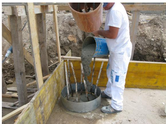
Successivamente si impermeabilizza la superficie della testa del palo, con l'X-tra impermeabilizzante a penetrazione cristallina.
