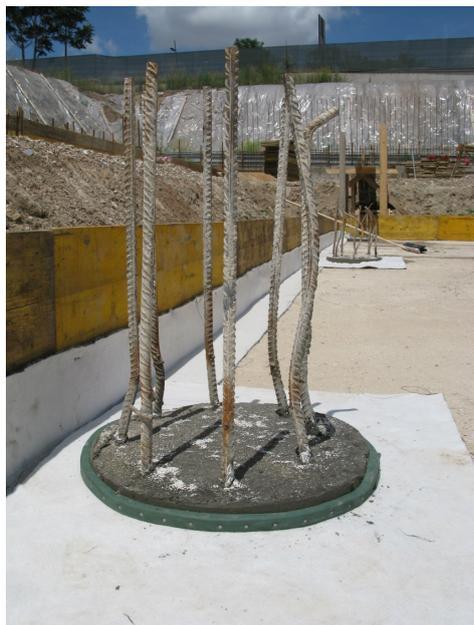
Sigillare ogni singolo ferro con il mastice idroespansivo Expanso.
