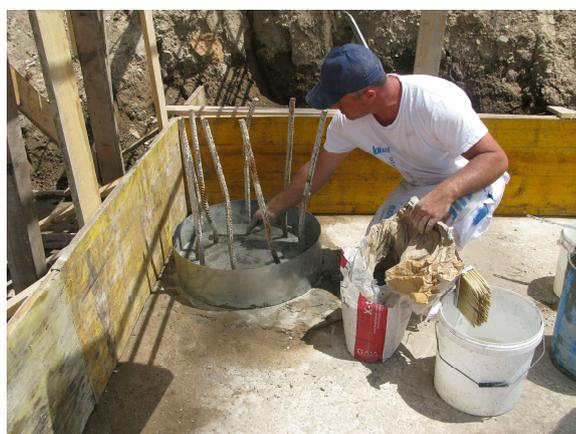
Dopo aver gettato e impermeabilizzato la testa del palo si posa il geocomposito bentonitico Bentoproof 5000 che viene applicato fino a ridosso della testa del palo, in modo da fasciarne l'intero perimetro.
