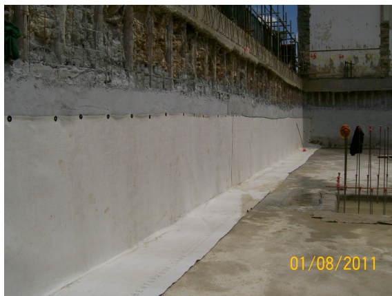
Chiusura delle sovrapposizioni con bandella metallica
