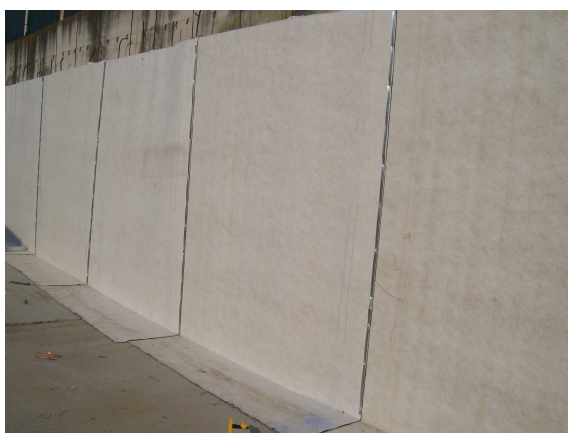
Chiusura delle sovrapposizioni con bandella metallica
